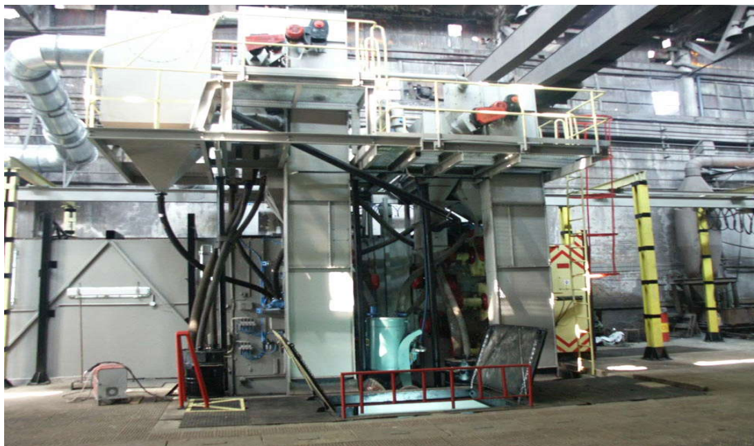
фиг. 4 Фрагмент от автоматизиран участък за почистване на метални повърхнини на изделия тип „колони“
