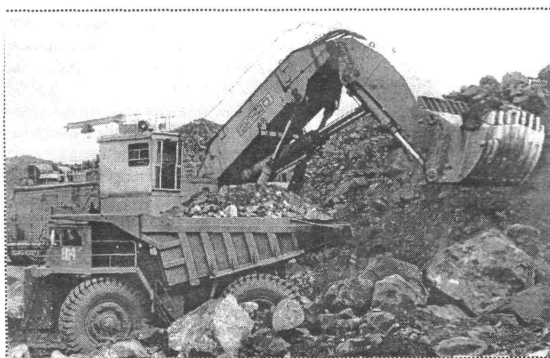
рис.3 Экскаватор ЭГ-20 в забое
