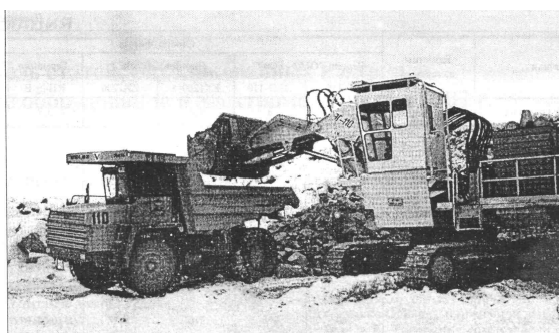
рис.8 Погрузка горной массы в автосамосвал экскаватором ЭГ-110
