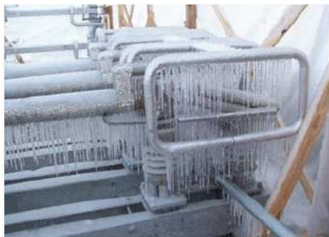
фиг.2 Обледена контактна система на разединител на Cleaveland/Price Inc.
