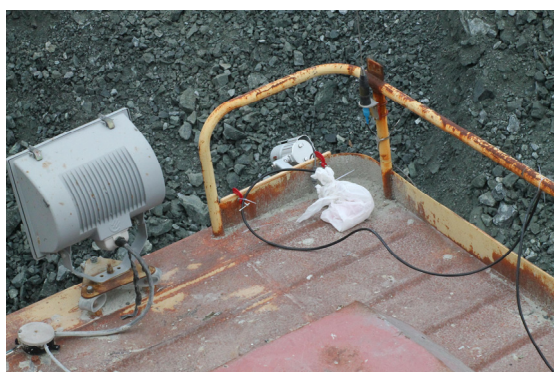
рис.19 Камера № 4 установленная на кабине
